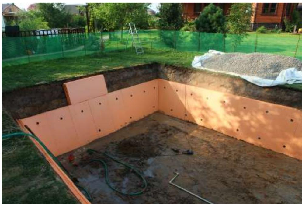
При утеплении котлована **не желательно** прокладывать утеплитель на дно котлована под подушку, так как это может привести к просадке основания подушки. В качестве утеплителя лучше всего использовать экструдированный пенопласт (пенополистирол) выпускаемый под марками Урса, Пеноплекс, Примаплекс, STYROFOAM
