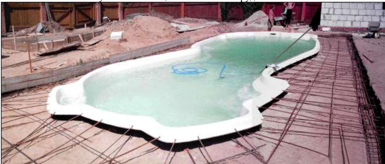
Рис 7.3. подготовка к бетонированию большой бетонной стяжки и фундамента под павильон. На рис. не изображены температурные компенсаторы.
