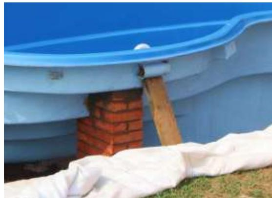
Максимальный допуск по горизонту при установке бассейна- 38 мм для моделей менее 9,5м в длину. Тот же допуск для моделей более 9,5м накладывается на 90% поверхности бурта. Допуск считается по внутренней кромке бурта и не распространяется на технологические подъемы/спуски бурта.
